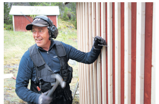
Ny fasad ska upp. Urban Nyberg spikar ribb.
